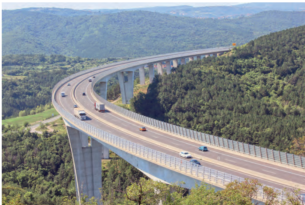
Slika 108: Viadukt Črni kal
