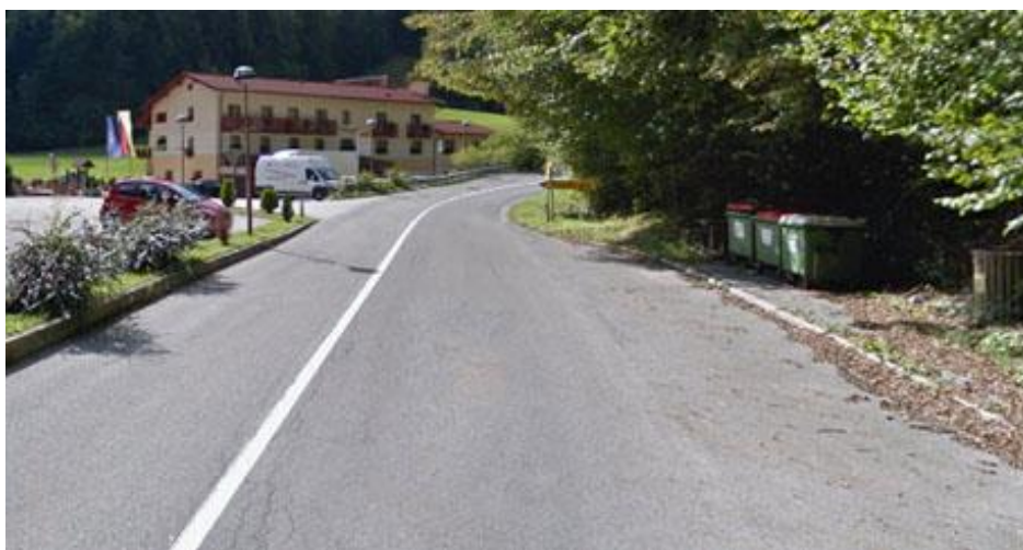
Slika 66: Vidrga (št. 2), prehod za pešce (slaba preglednost)
