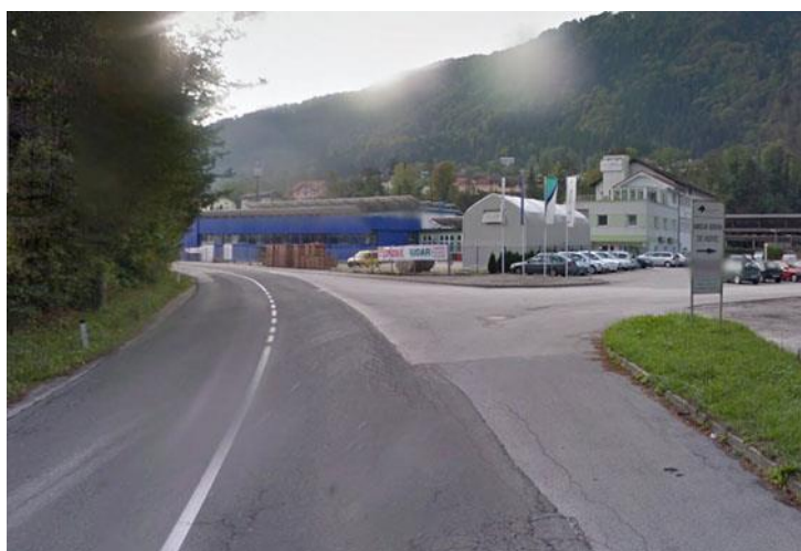
Slika 75: Kritično mesto št. 16 – območje nekanaliziranega križišča ceste R 221 in ceste v Borovniško naselje
