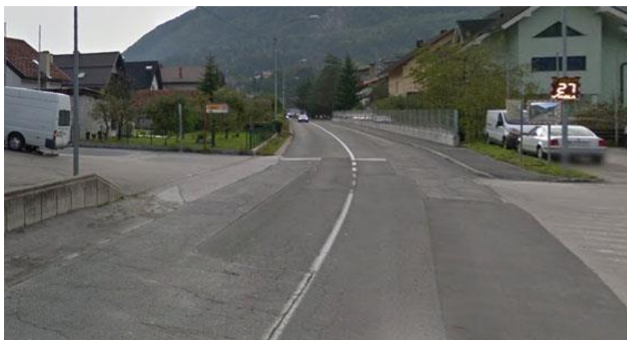
Slika 76: Kritično mesto št. 17 – križišče z Jevšnikovo ulico
