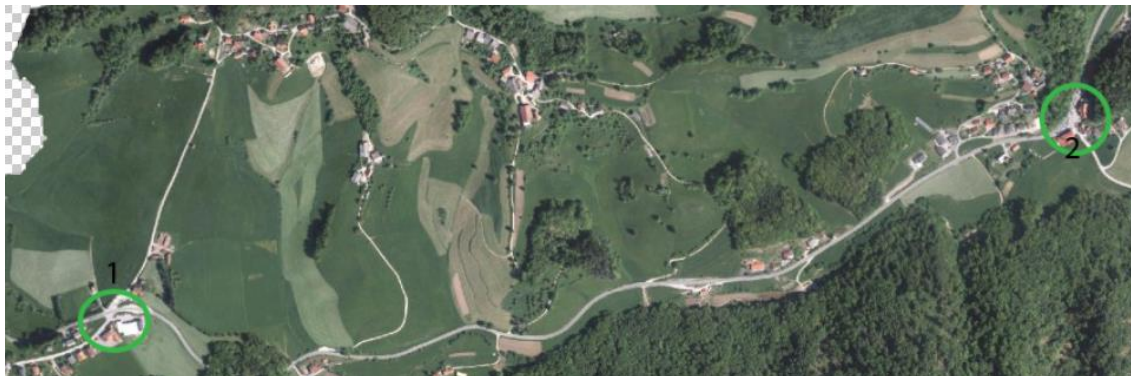
Slika 64: Kritični točki na cestni infrastrukturi-Kandrše (št. 1) in Vidrga (št. 2)
