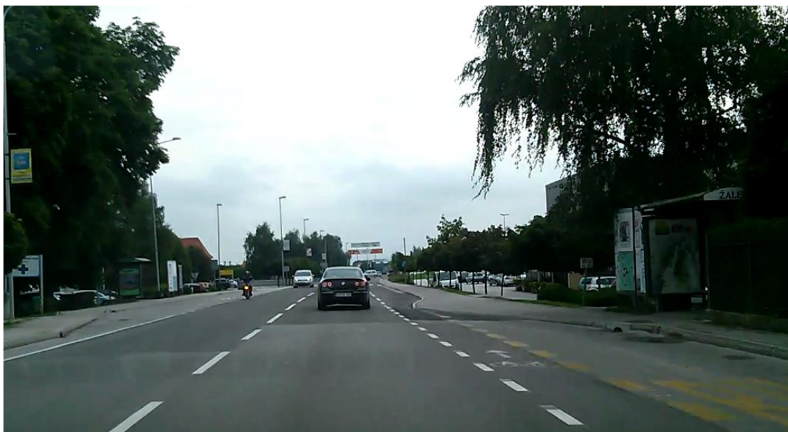
Slika 64: Žalec: Celjska cesta, v smeri iz centra pas za kolesarje, označen na cestišču, ki preide v pas za desne zavijalce na cestišču
