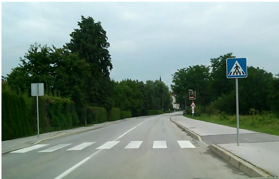
Slika 74: Žalec: Ulica Savinjske čete, Denivelacija pločnika pri prehodu za pešce
