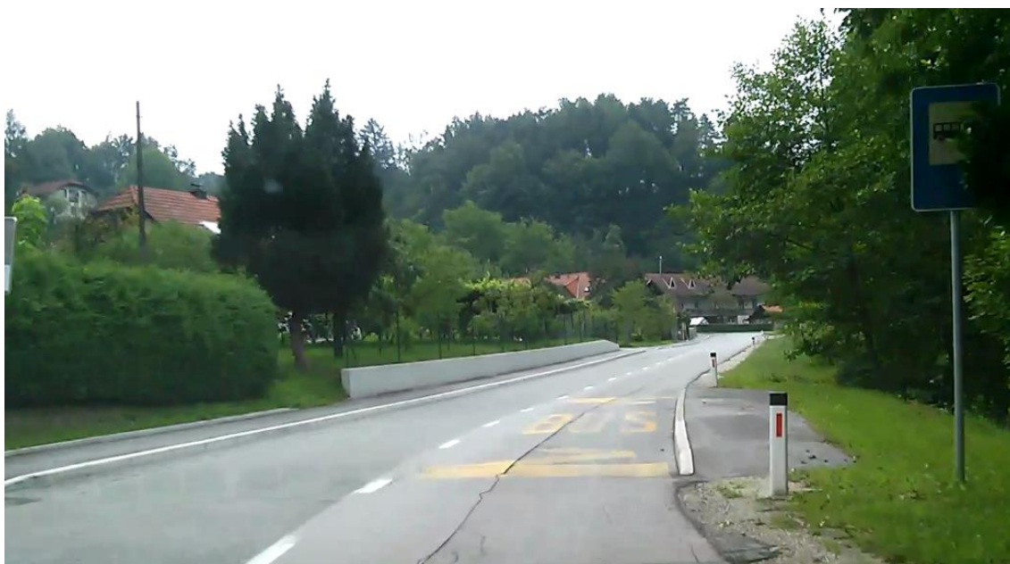
Slika 44: Zabukovica: Avtobusna postaja na vozišču brez nadstrešnice
