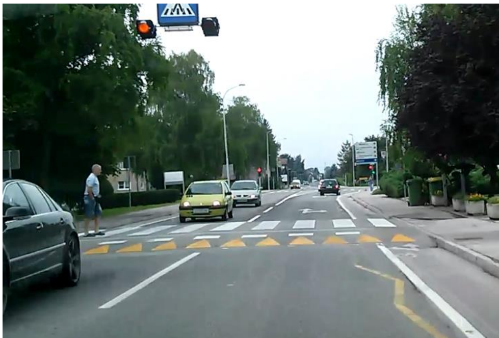
Slika 63: Žalec: Celjska cesta – prehod za pešce, kolesarska pot in pločniki, talne označbe za umirjanje prometa
