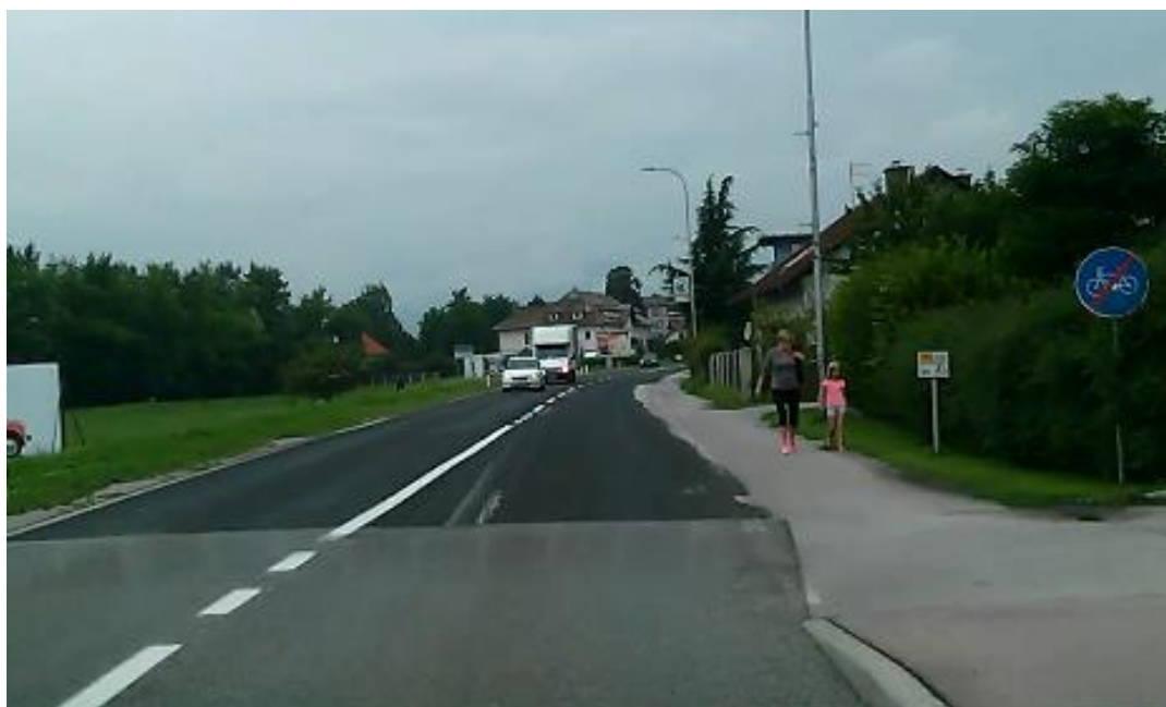
Slika 71: Šempeter: Konec kolesarske poti ob glavni cesti v smeri proti AC
